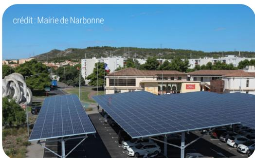
Les ombrières de parking assurent une double fonction : la production d'électricité et la protection des véhicules contre le soleil et les intempéries. Elles utilisent un espace qui a déjà une fonction, et possèdent une architecture adaptée au milieu urbain.
