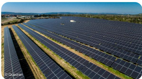
De quelques kiloWatts-crêtes (kWc) chez un particulier, à plusieurs MégaWatts-crêtes (MWc), les centrales au sols (CAS) ont l'avantage de pouvoir s'implanter sur de nombreux types de terrain, et ainsi de permettre de choisir les meilleures orientations et inclinaisons pour les panneaux.
